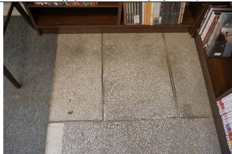
Kanał instalacyjny c.o. w pomieszczeniu z lastrikiem
