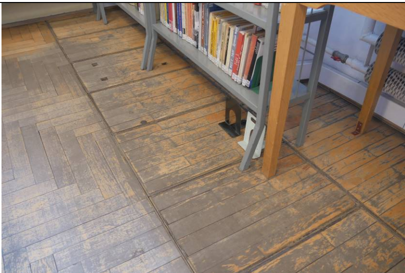
Kanał instalacyjny c.o. w pomieszczeniu z parkietem
