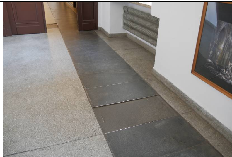
Kanał instalacyjny c.o. w komunikacji z posadzką lastriko
