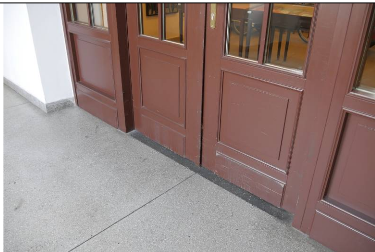
Posadzka lastriko przy stolarce drewnianej
