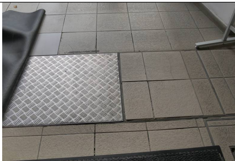
Kanał c.o. w wejściu głównym (posadzka ceramiczna)
